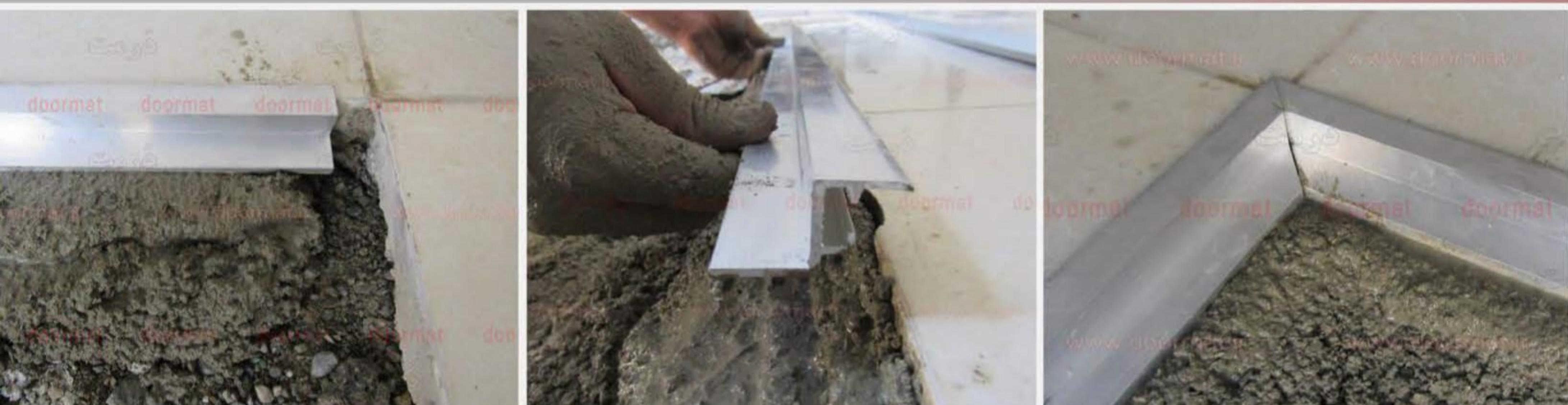
پروفیل آلومینیومی Z برای اجرای توکار پادری های ۲ سانتی با تردد زیاد تولید شده با استفاده از این پروفیل عمق نیاز پادری تامین میشود و از لبه های سرامیک یت سنگ کف نیز محافظت میشود
