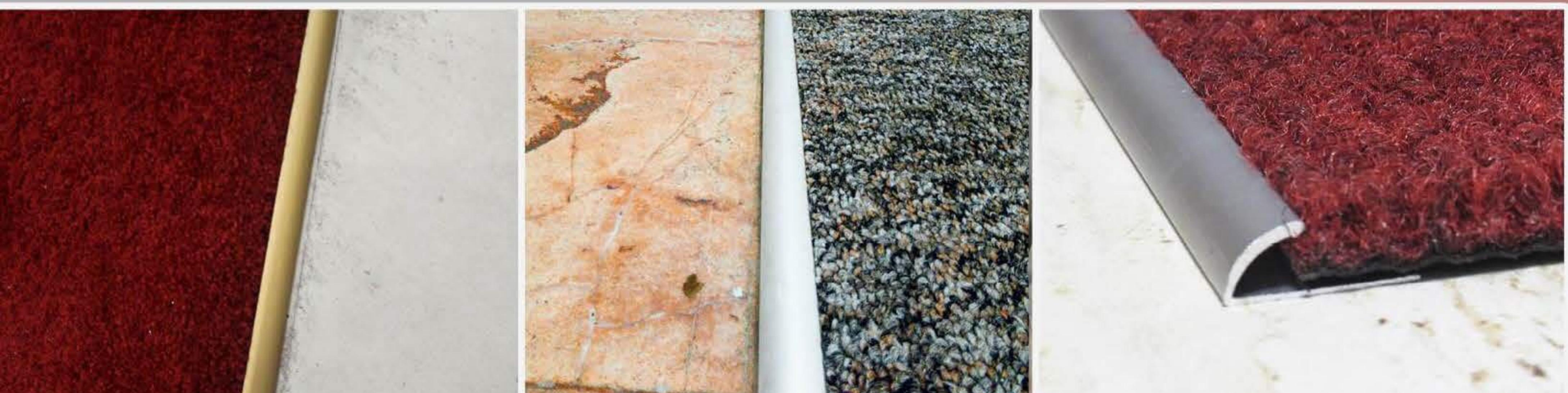
پروفیل آلومینیومی تمام کننده موکت در انتهای موکت در استفاده می‌شود در فضاهایی که موکت روی کف اجرا شده نصب می‌شود در انتهای لبه های موکت امکان بلند شدگی موکت بر اثر داخور بودن وجود دارد با نصب این پروفیل روی زمین و قرار دادن موکت داخل آن میتوان از پاگیر بودن موکت جلوگیری نمود و نمای بهتری را برای لبه موکت ایجاد نمود
